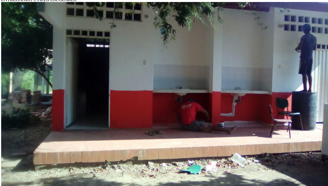
MANTENIMIENTO DE BAÑOS
