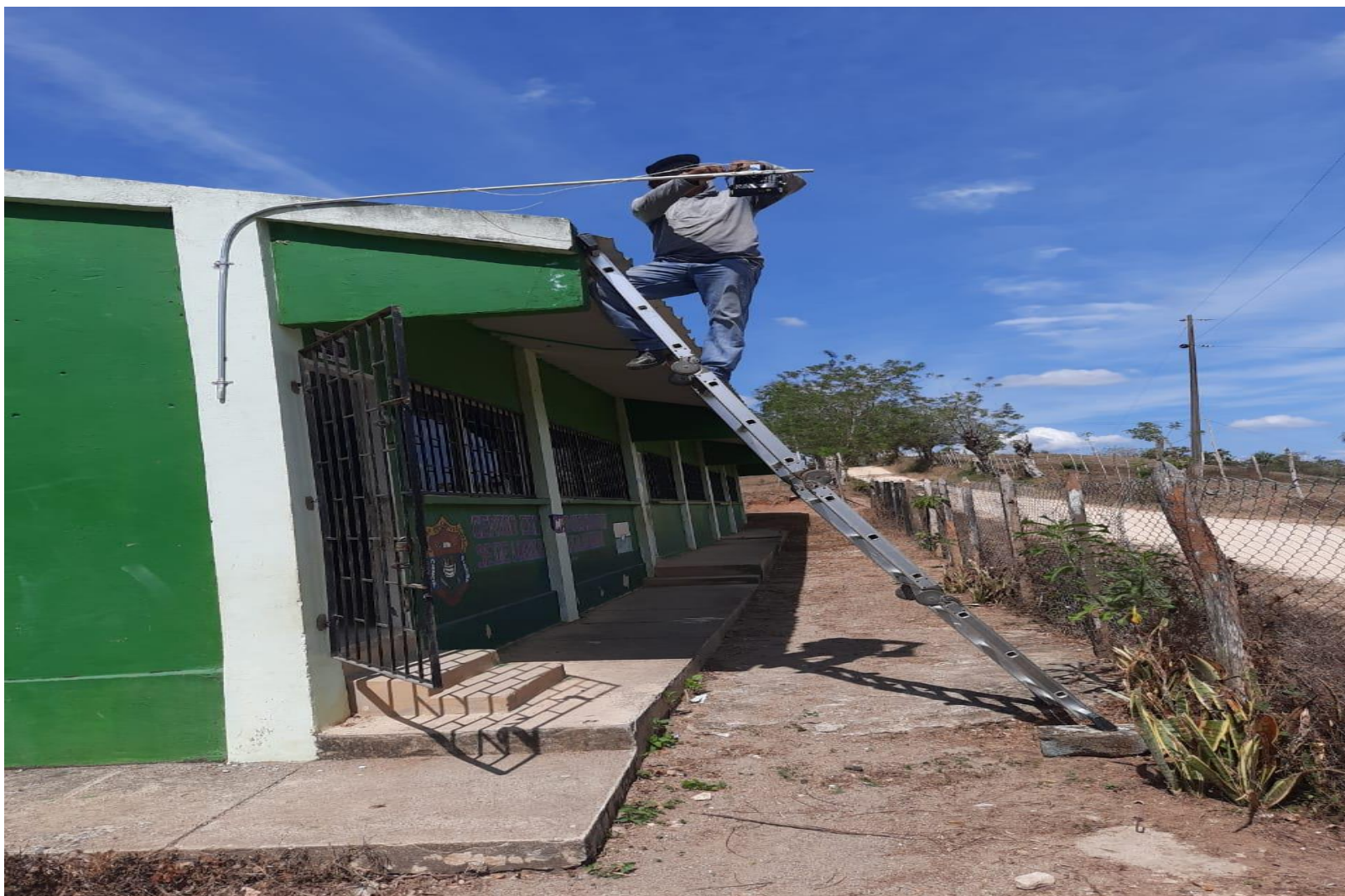
INSTALACION DE REFLECTORES CON FOTOCELDAS PARA LA SEDE MARIA AUXILIADORA
