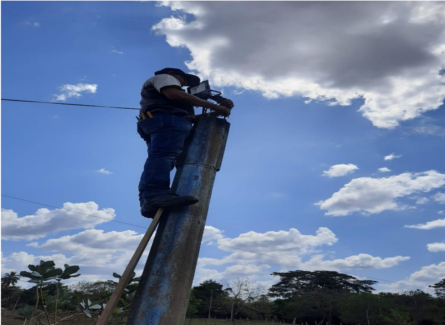
INSTALACION DE REFLECTORES CON FOTOCELDAS PARA LA SEDE LORANOS MEDIO
