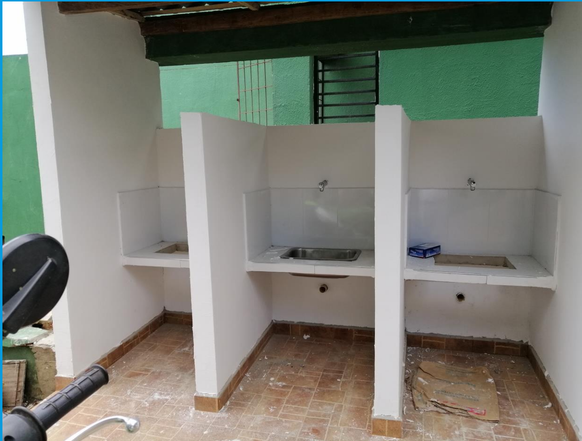
ADECUACIÓN DE ZONA DE LAVADO DE MANOS
