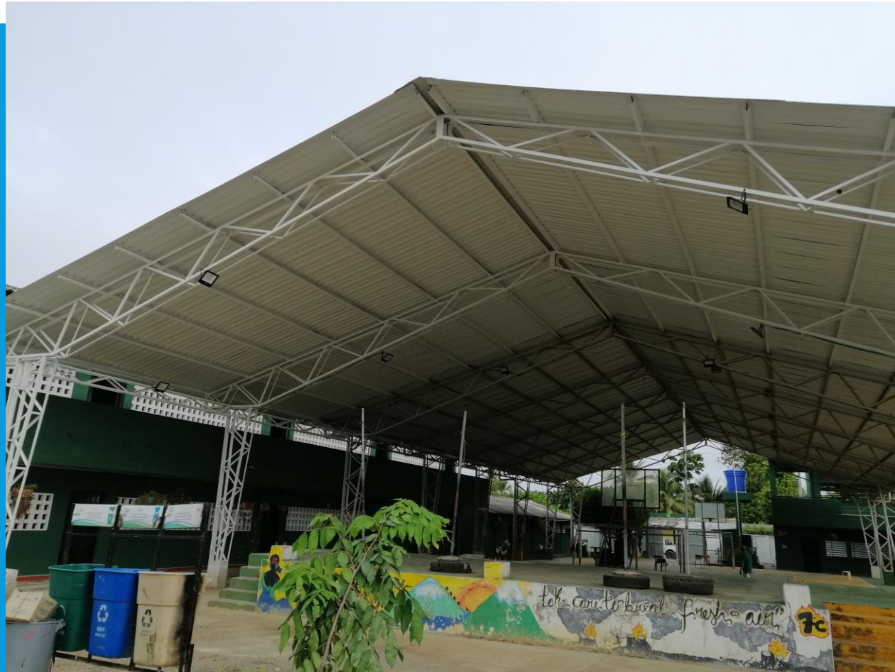
PROLONGACION CUBIERTA CANCHA DEPORTIVA.
