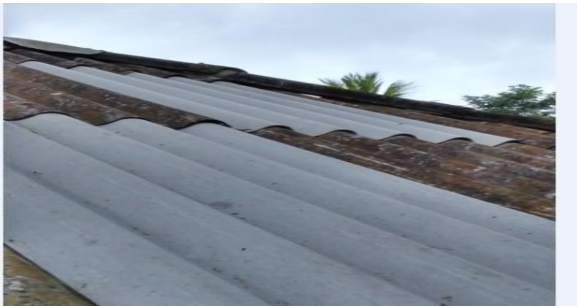
ARREGLO DE TECHO Y OTROS SEDE CEDRO POR DAÑOS AL INICIO 2020
