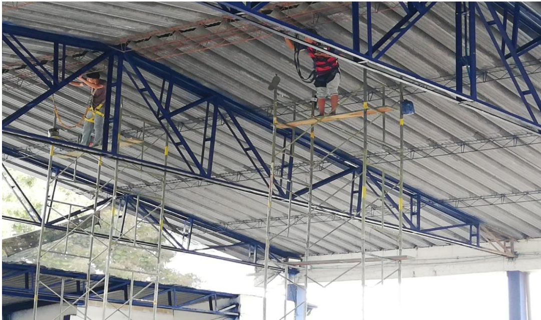
Mantenimiento de estructura metálica Polideportivo
