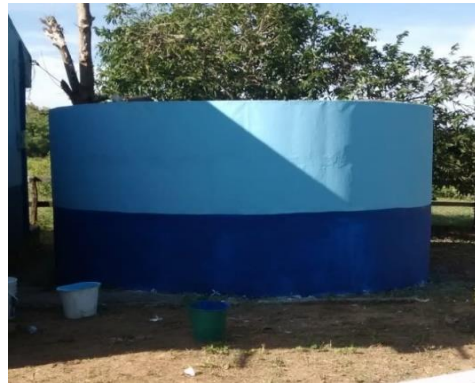
Curado del tanque de Almacenamiento con Sikatop 107 y mantenimiento de pintura. Sede Providencia
