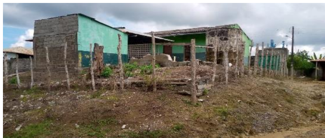
Cercado en Madera y Alambre puas para cercado perimetral. Sede Villa Esther
