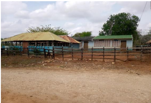
Estado anterior de la sede Arroyo Arena Mangle
