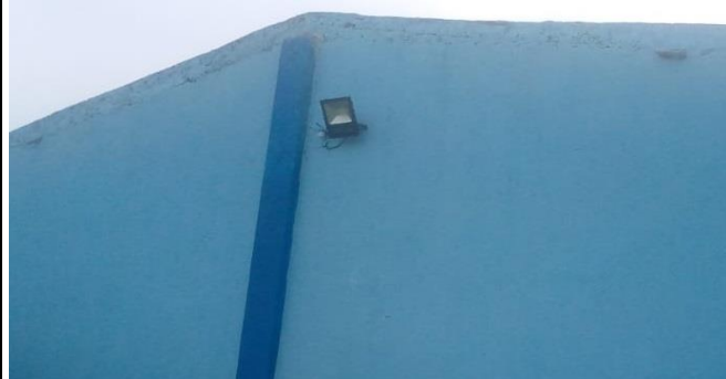
Suministro e Instalacion de reflector, incluye fotocelda. Sede Providencia
