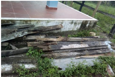
Se aprecia los postes y varetas que se retiraron del cercado perimetral de la sede El Libano.
