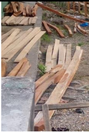
Suministro de Postes y Varetas para cercado perimetral sede Villa Esther
