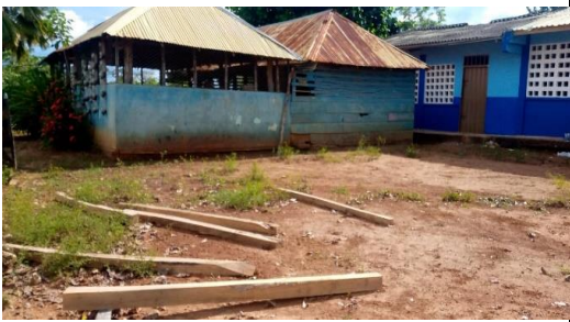
Suministro e instalacion de postes del cercado externo. Sede Arroyo Arena
