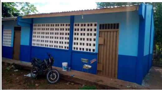
Pintura tipo 1 ,externa y interna de aulas en la sede Arroyo Arena
