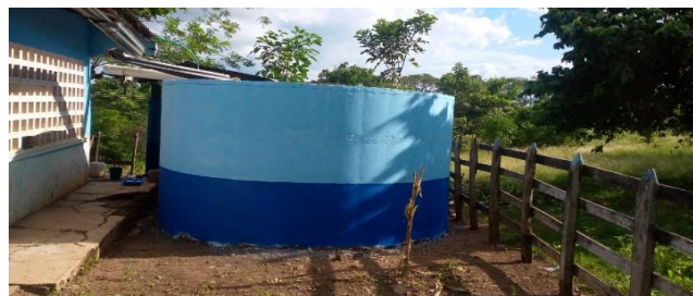
Curado del tanque de almacenamiento de aguas con Sikatop 107 y pintura externa tipo 1. Sede Arroyo Arena
