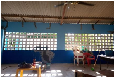
Arreglo de grietas de paredes . Sede Arroyo Arena
