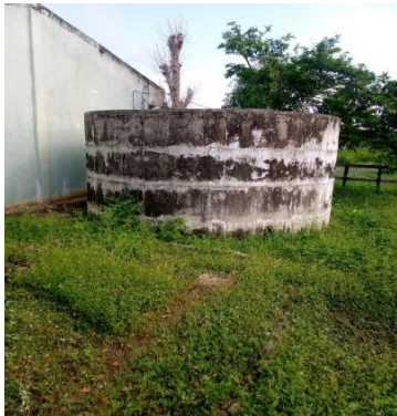
Estado Anterior del Tanque de Almacenamiento de aguas lluvias. Sede Providencia
