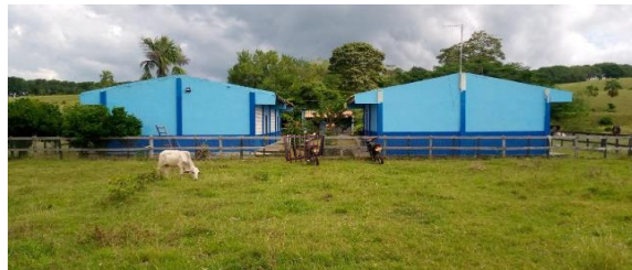
Estado actual, se evidencia mantenimiento de Pintura y reflector de iluminacion externa sede Providencia, incluye Puerta Metalica. Sede Providencia
