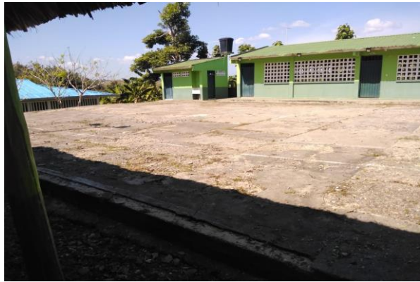
Cambio de reflectores quemados . Sede Villa Esther
