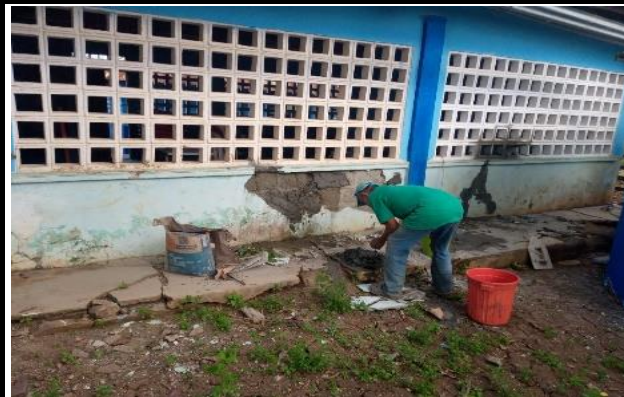
Reparacion de muros- sede Arroyo Arena
