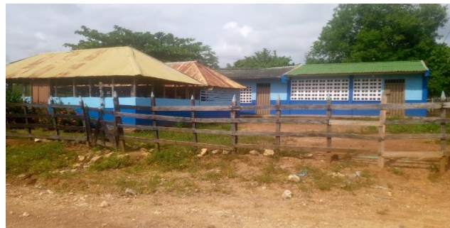
Mantenimiento de la pintura Interna y Externa con pintura Tipo 1. sede Arroyo Arena
