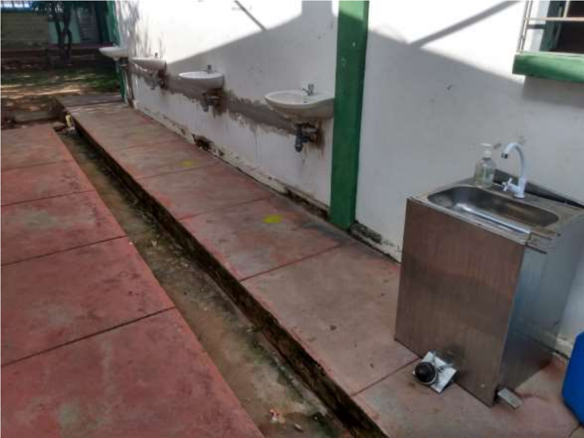
INSTALACIÓN DE LAVAMANOS
