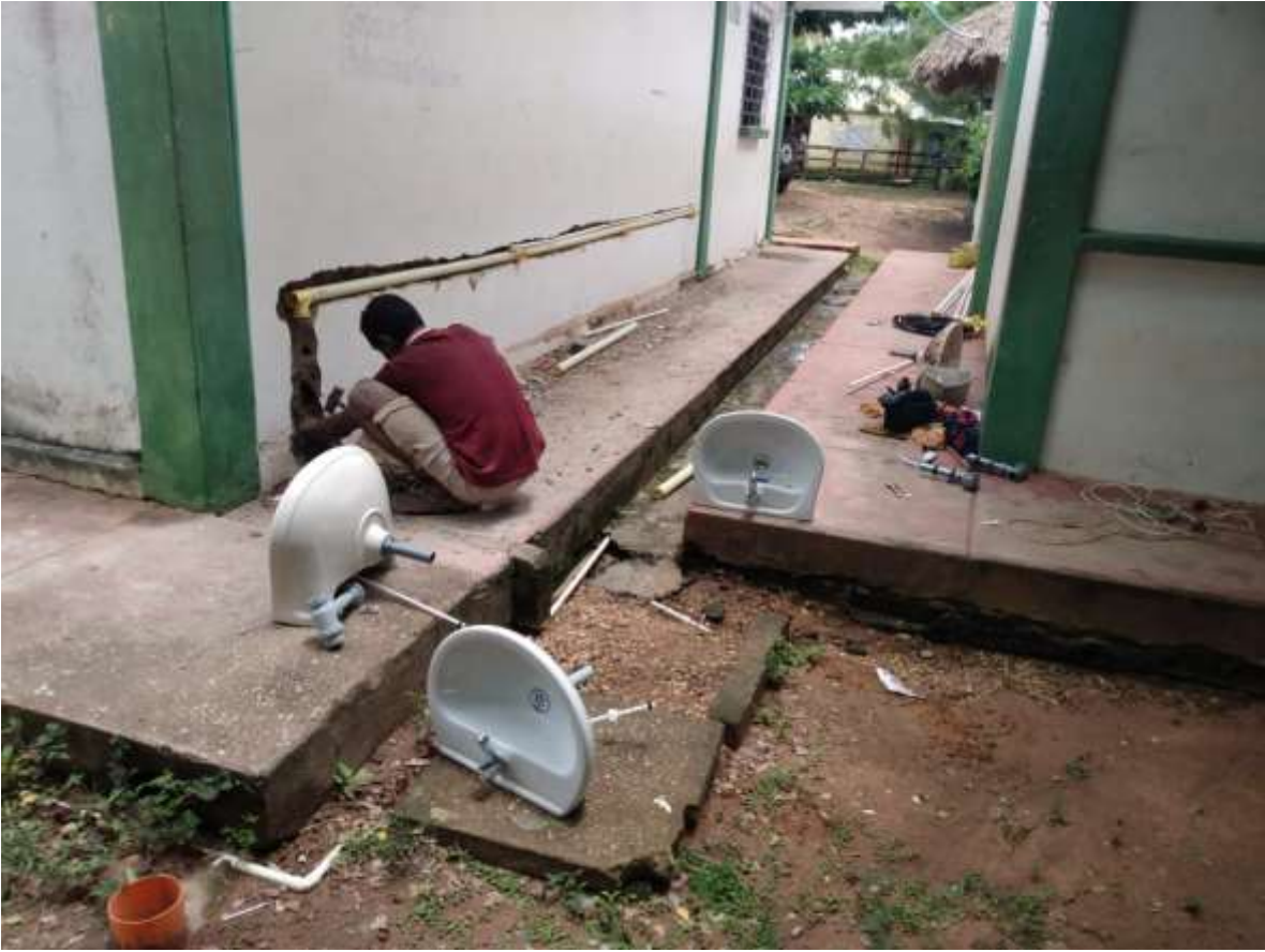
INSTALACIÓN DE LAVAMANOS
