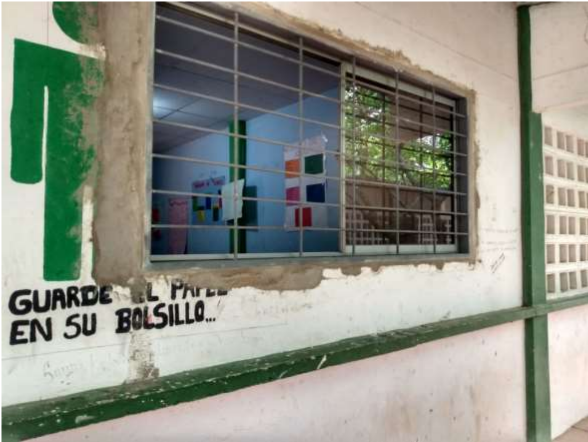
INSTALACIÓN DE VENTANAS
