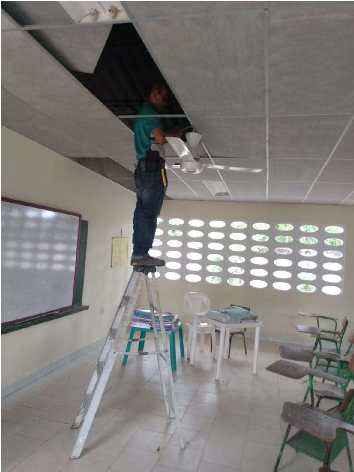
MANTENIMIENTO CIELO RAZO
