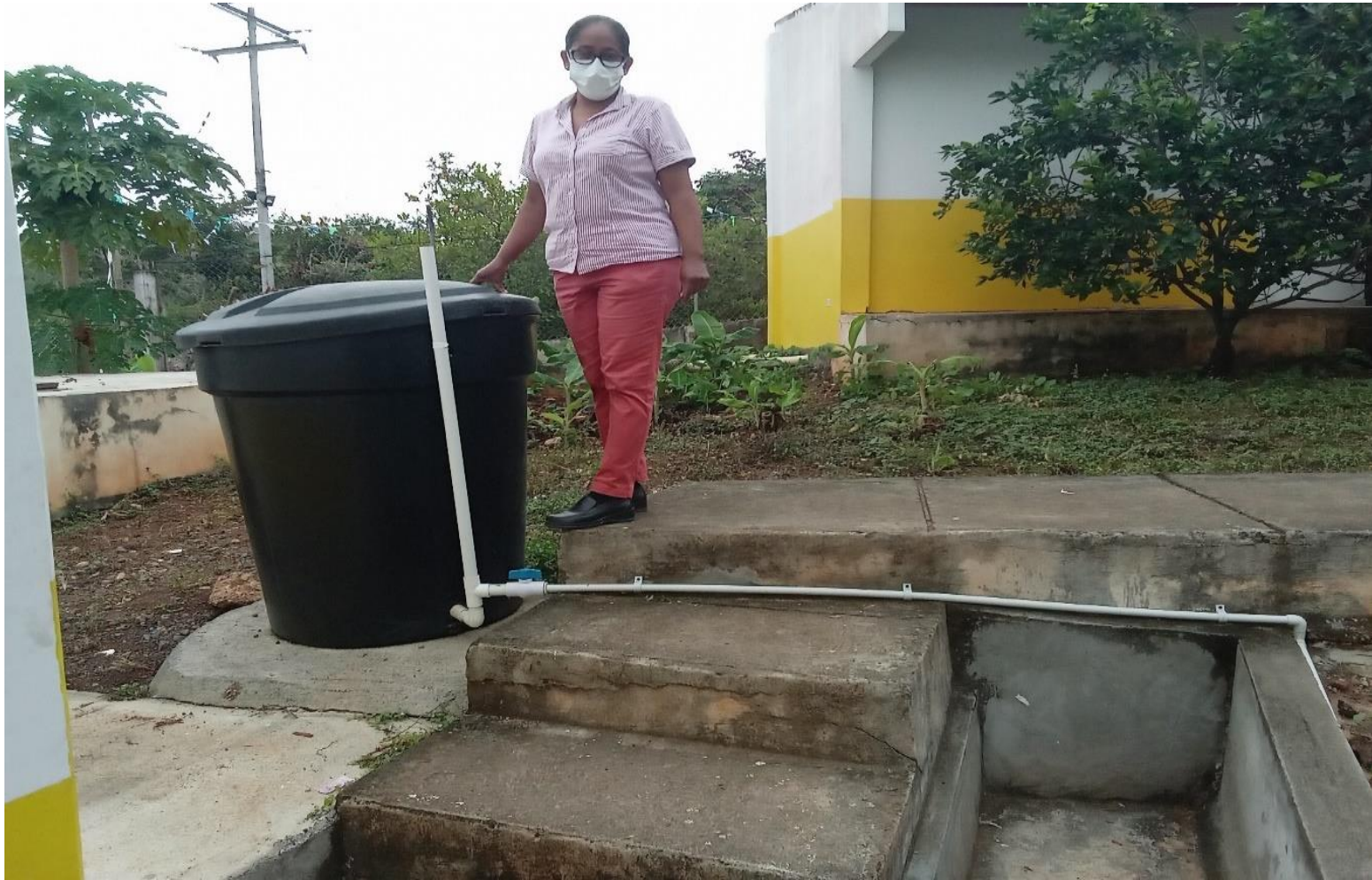
Instalación de tanque elevado – sede principal
