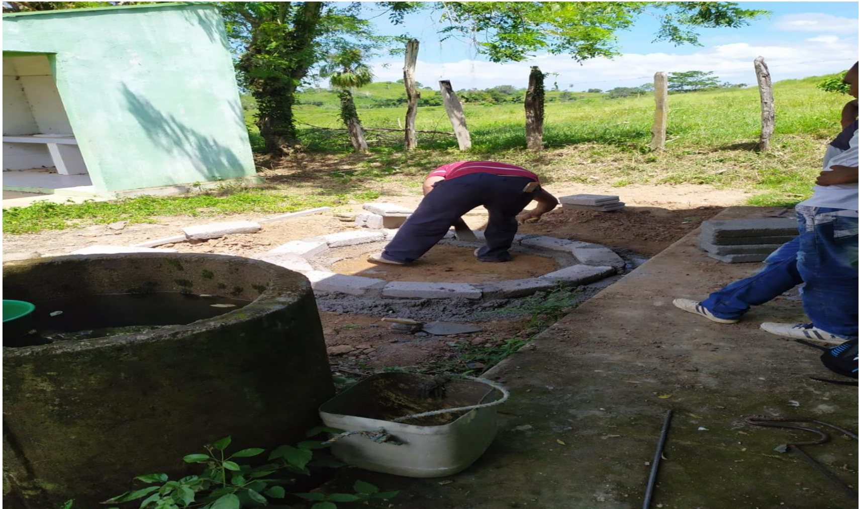
Construcción de rampla para montar tanque elevado en la sede María Auxiliadora
