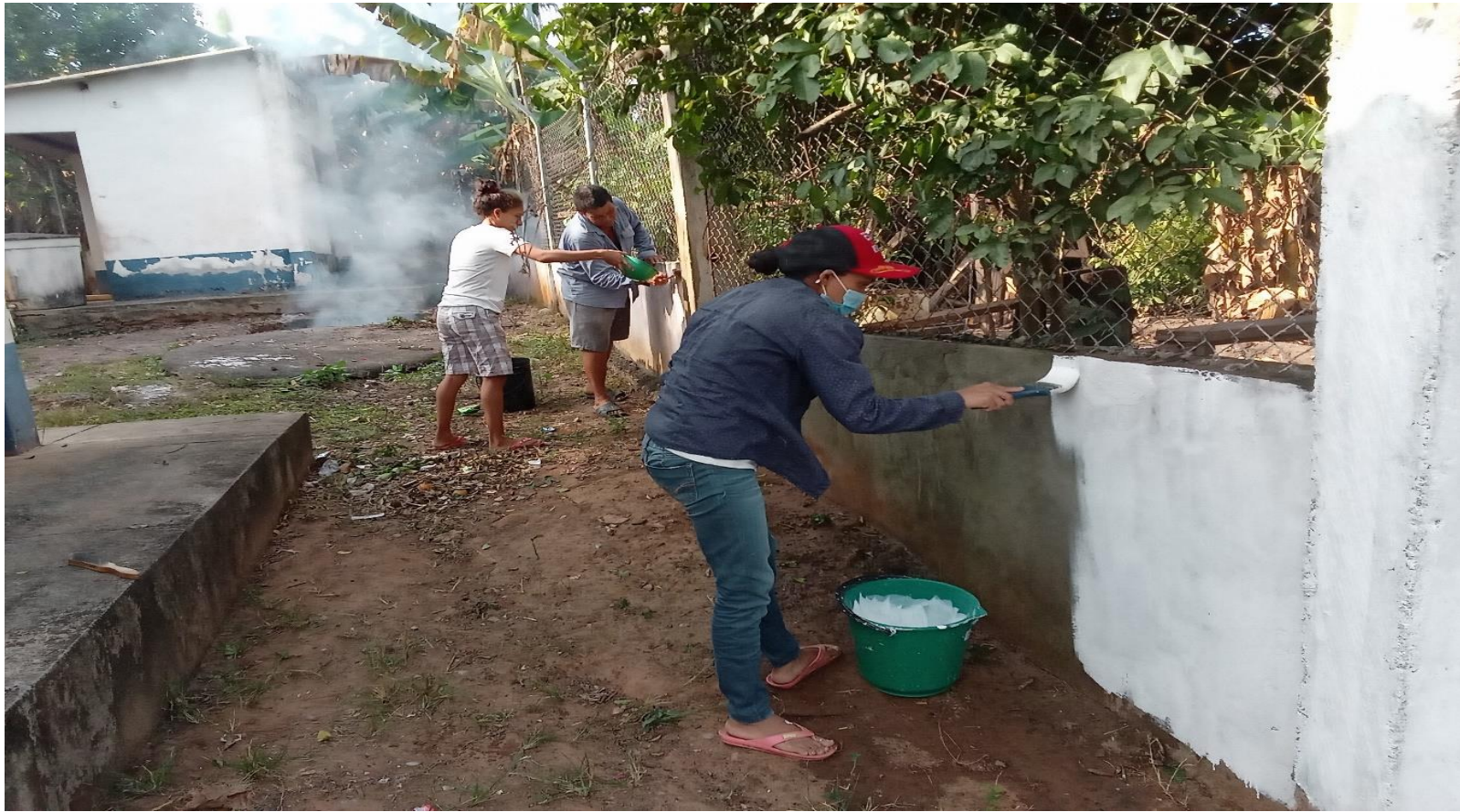
Pintura de Encerramiento - sede Cienaguita
