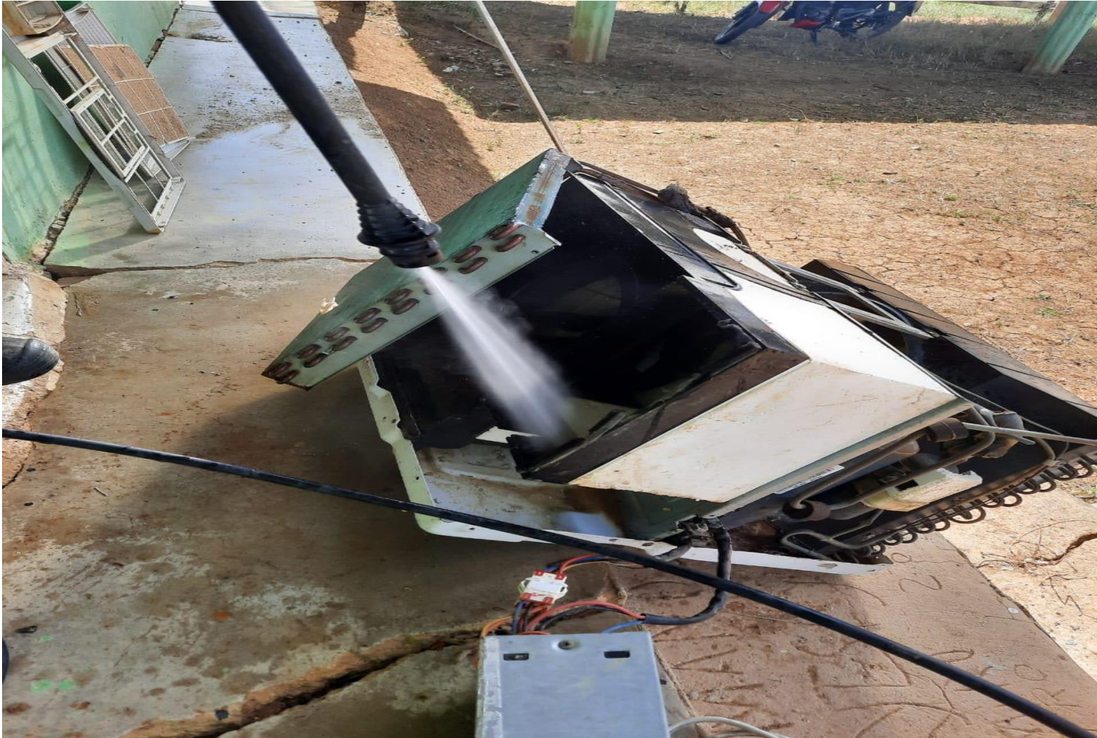
Mantenimiento de aire acondicionado
