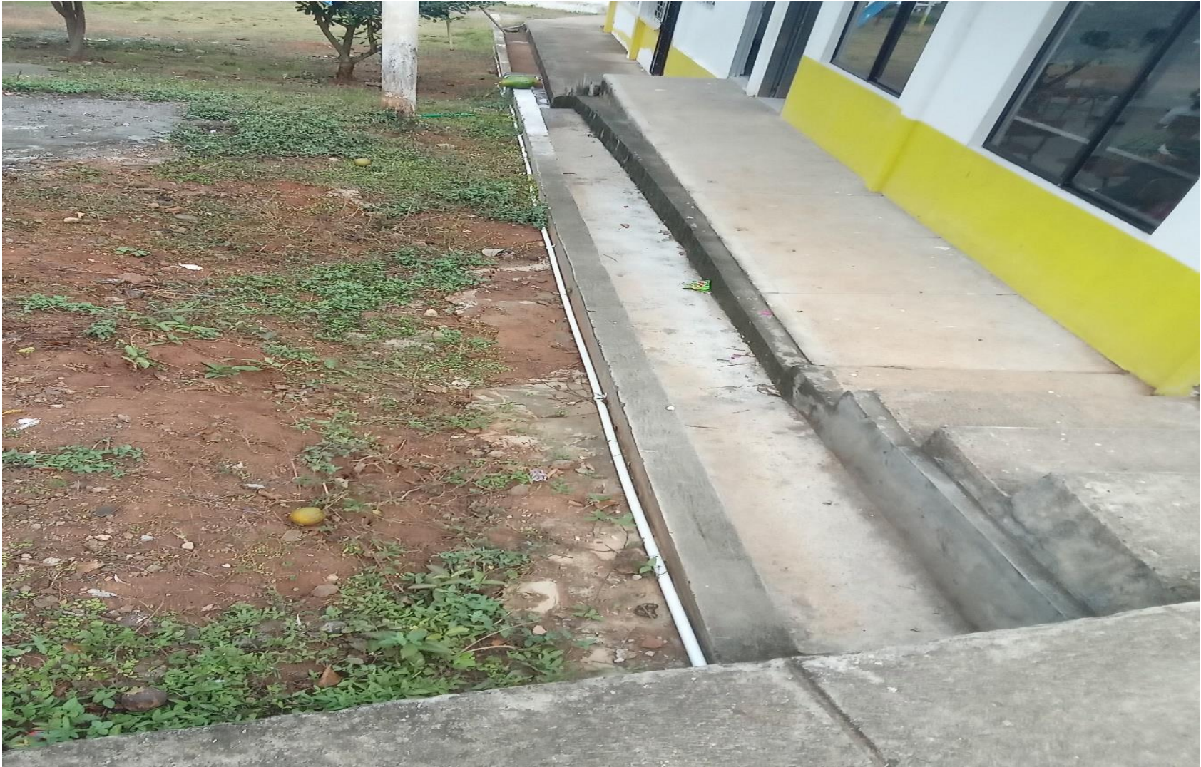
Instalación de tuberías y grifos para el agua
