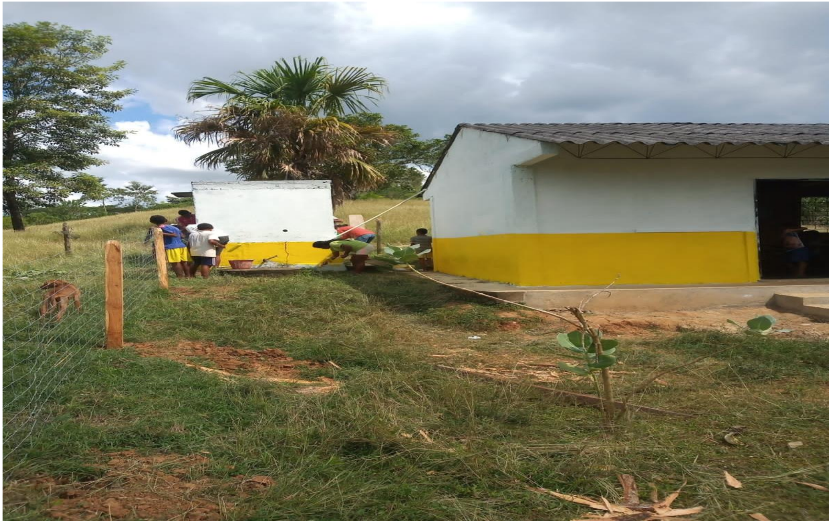
Trabajo de encerramiento en la sede Loranos medio
