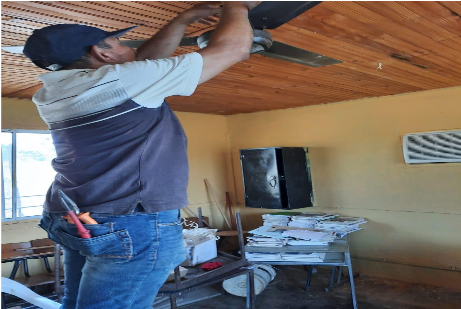
Instalación de ventiladores
