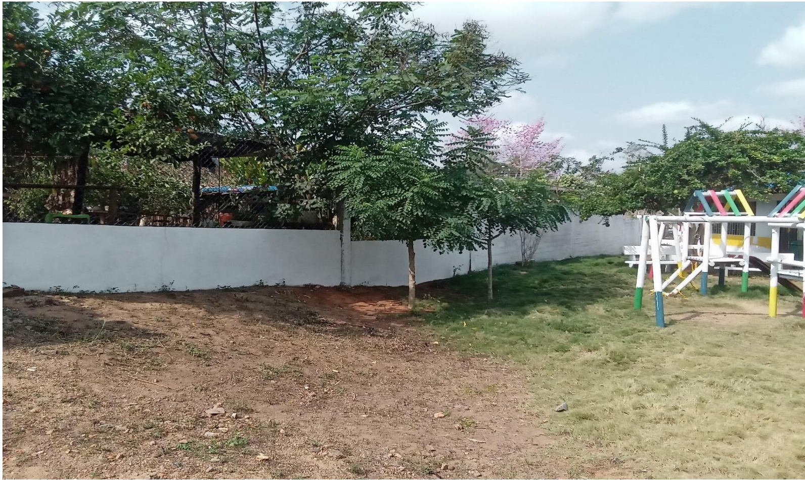
Pintura de encerramiento sede Cienaguita
