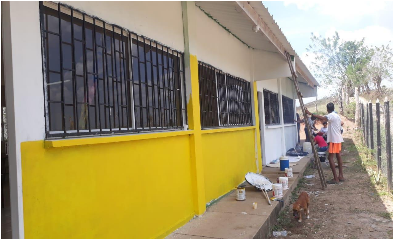
Trabajo de pintura en la sede Maria Auxiliadora
