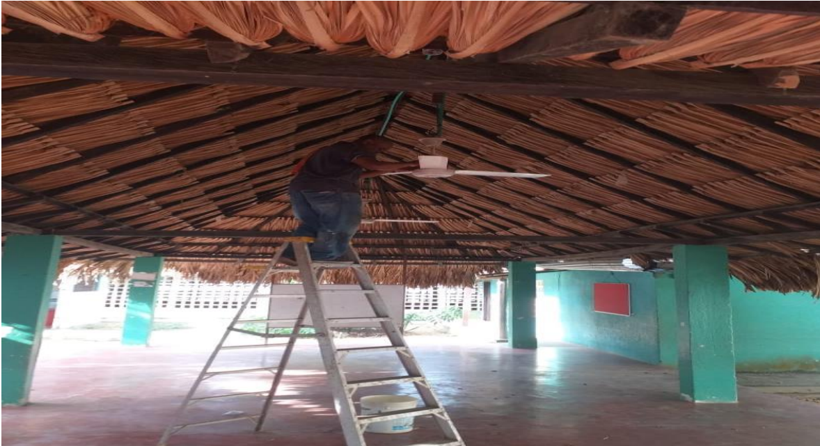
Instalación y Arreglo de Redes eléctrica y Otros, Cedro x robo
