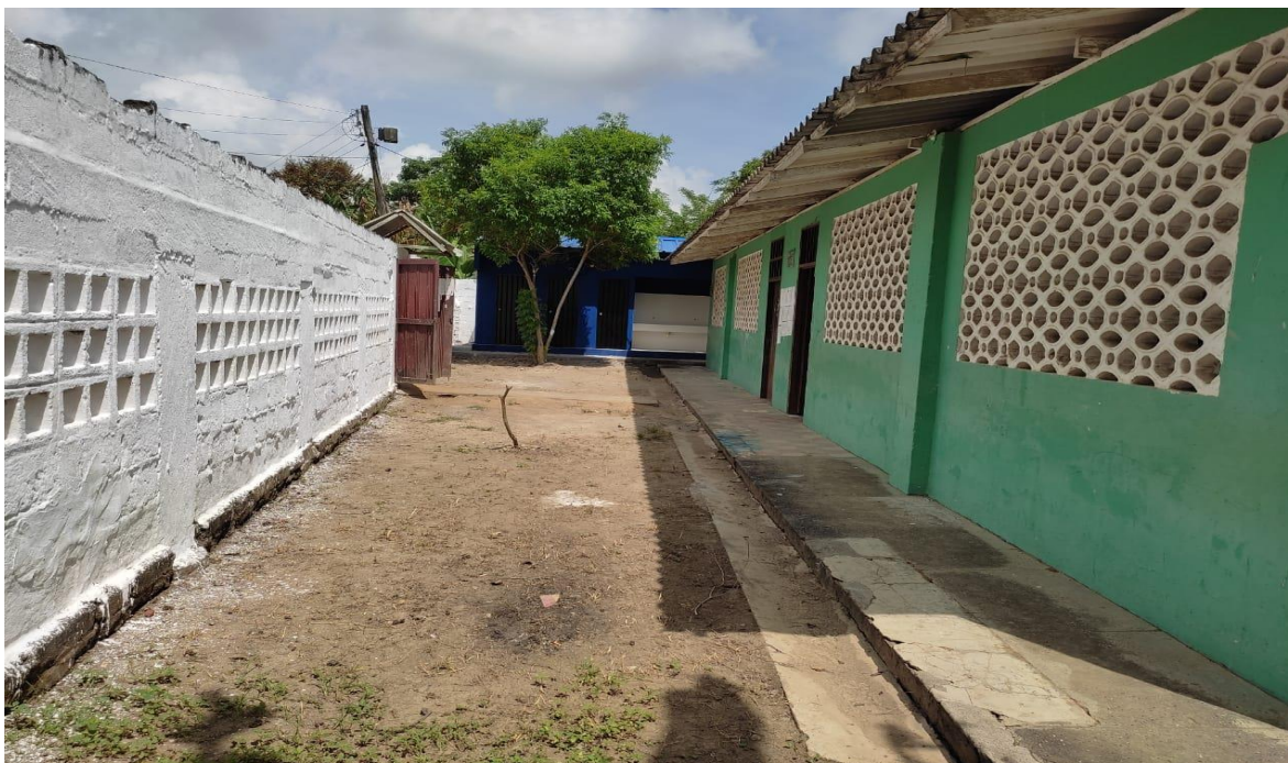
Mantenimiento Físico y espacio escolar por sede Año 2021
