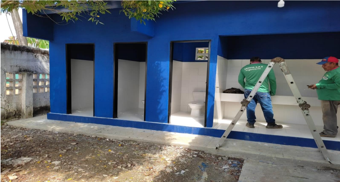
Construcción de Unidad Hidrosanitaria sede Escuela El Cedro 2021x Mpio
