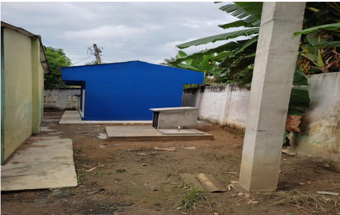
Construcción de Unidad Hidrosanitaria sede Escuela El Cedro 2021 x Mpio
