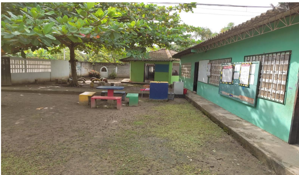
Mantenimiento Físico y espacio escolar por sede Año 2021
