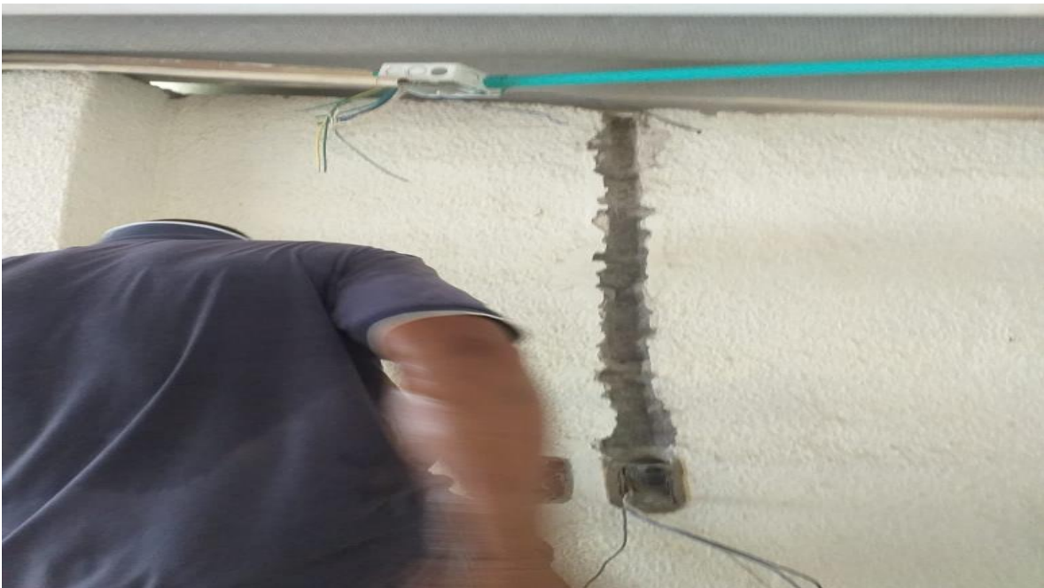
Instalación y Arreglo de Redes eléctrica y Otros, Cedro x robo
