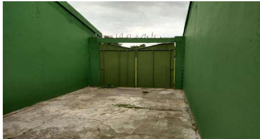
ELABORACION DE PORTON SALIDA A CANCHA DE FUTBIL 2020
