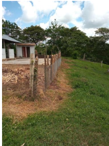
Arreglo y mantenimiento de cerca sede el descanso.
