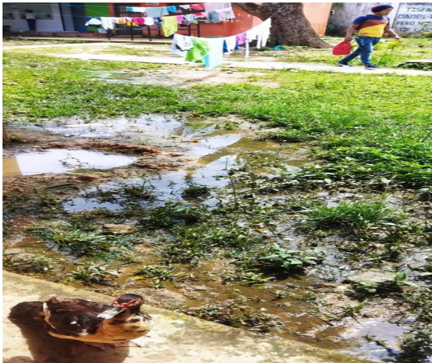
INVASIÓN DE AGUAS NEGRAS POR COLAPSO DE POZA SÉPTICA
