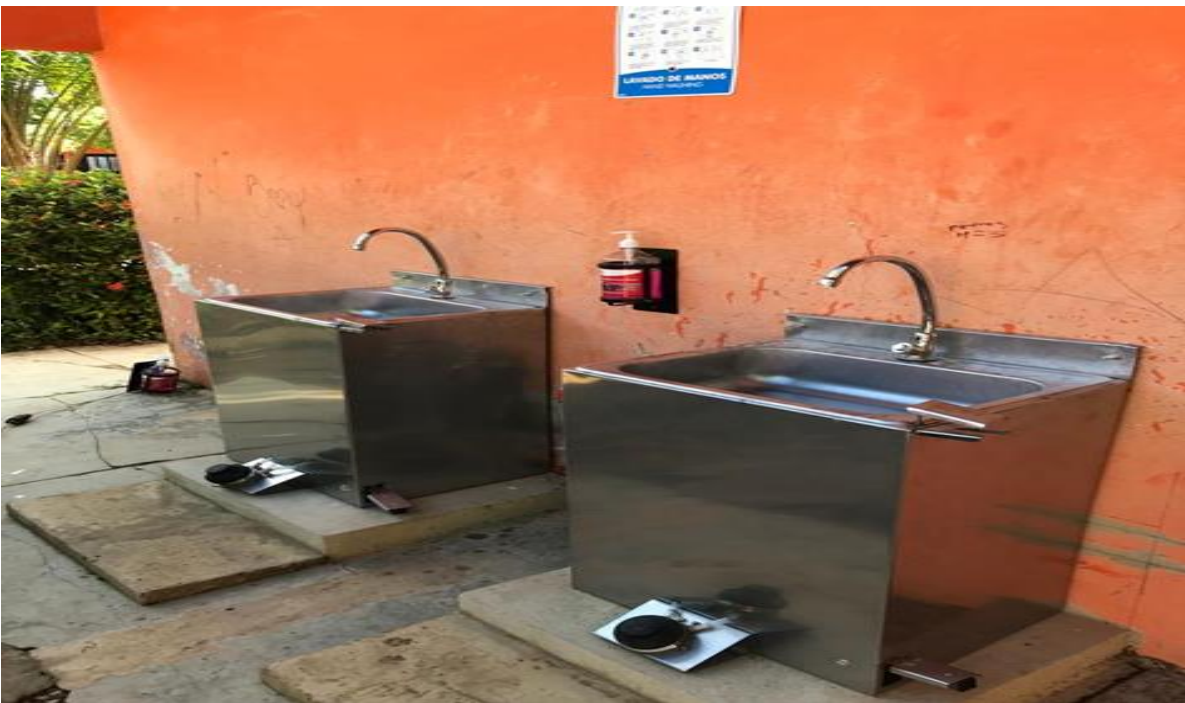
INSTALACION LAVAMANO ENTRADA DE LA INSTITUCION
