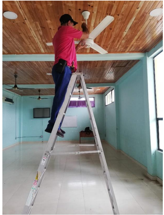
Mantenimiento de equipos de aires acondicionados y ventiladores
