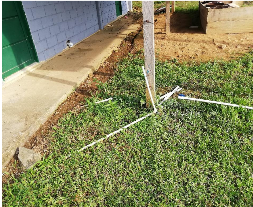
ARREGLO DE LOS CANALES AGUA LLUVIA
