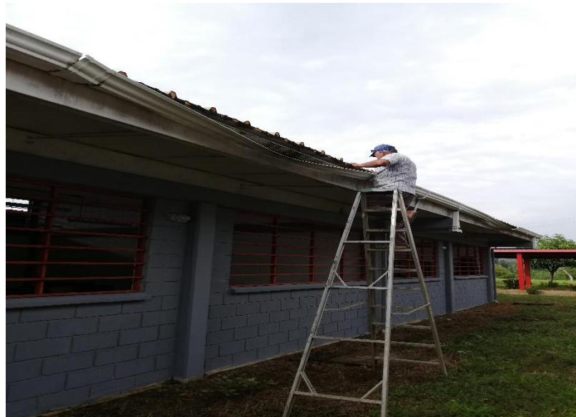
ARREGLO DE LOS CANALES AGUA LLUVIA
