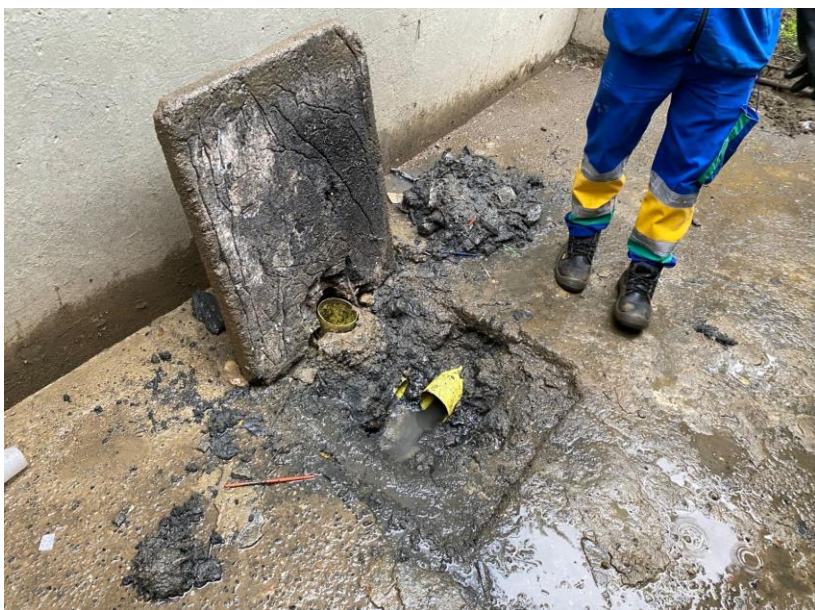
MANTENIMIENTO AL ALCANTARILLADO
