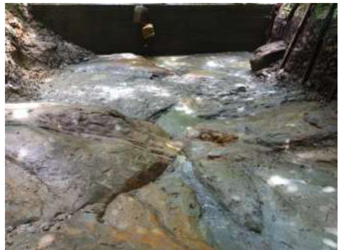
Ilustración 1 LIMPIEZA BOCA TOMA (SUMINISTRO DE AGUA)
