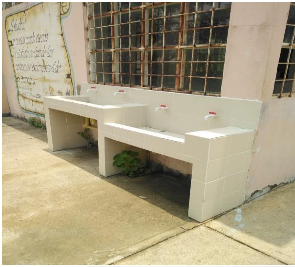
Foto 2. Construcción lavamanos enchapados de mortero o piso placa del patio cerca de la tarima y del pozo.
