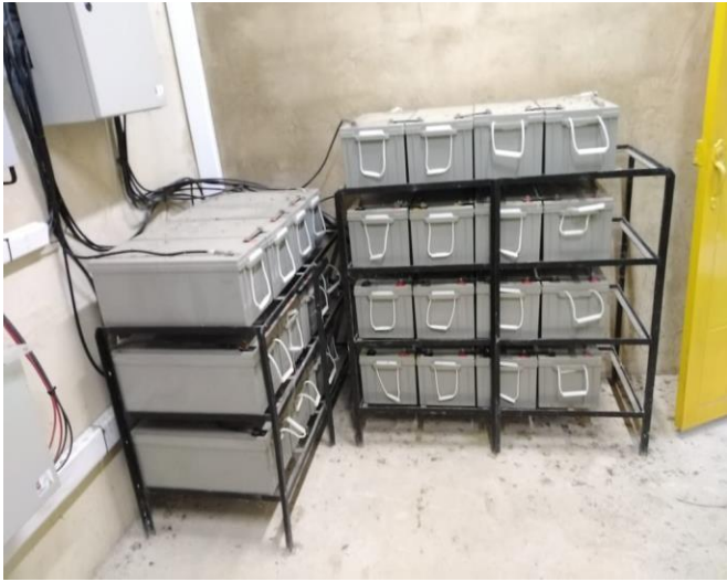
Foto 4. Desinstalación e instalación de baterías de poder de energía solar, para prevenir posibles daños por inundación provocada por el desbordamiento del río cauca
