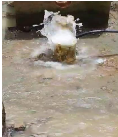
Foto 5. Limpieza y desinfección del pozo taladrado de 55 mts de profundidad e instalación de una bomba sumergible de lapicero, lavado de cinco (5) tanques de almacenamiento de agua potable en la sede principal de la IE Sincelejito
