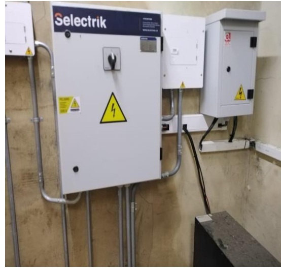
Foto 4. Desinstalación e instalación de baterías de poder de energía solar, para prevenir posibles daños por inundación provocada por el desbordamiento del río cauca
