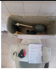
Mantenimiento de Sanitarios
