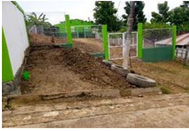
Adecuacion Area entrada, incluye Pintura 2021
