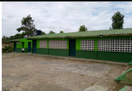
Mantenimiento de Pintura aulas de 3° y 5°
