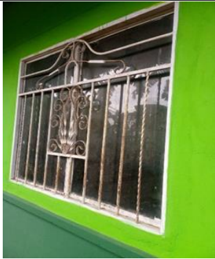
Ventanas del KVD antes del mantenimiento
